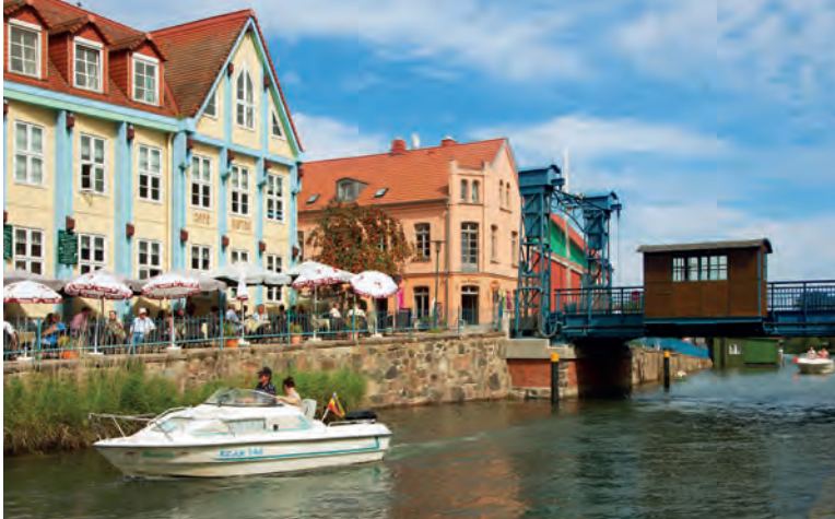
Die denkmalgeschützte blaue Hubbrücke in Plau am See
